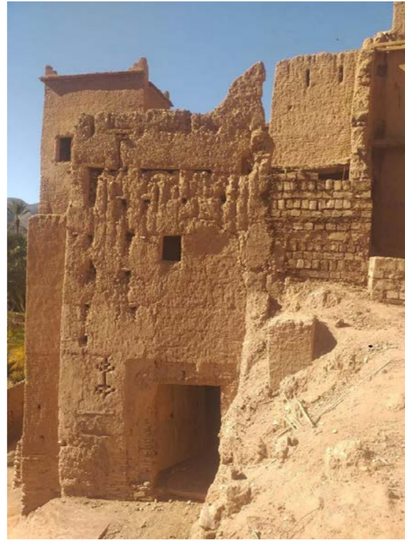
Porte du Mellah, reprise de la façade
