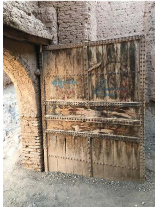
Porte d'Asslim, avant dégagement
