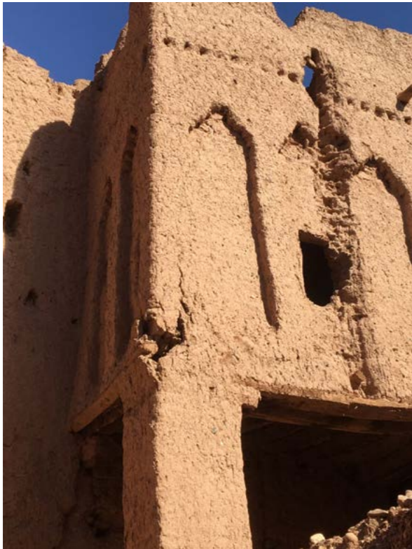
Porte du Mellah, côté ksar, avant restauration
